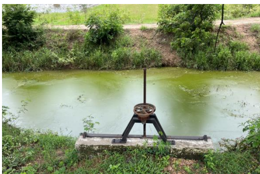
รูปที่ 2-14 จุดระบายน้ำฝนออกจากนิคมฯ
